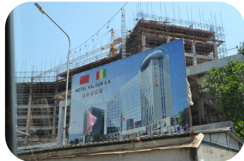
Hotel Kaloum 5* en construction
