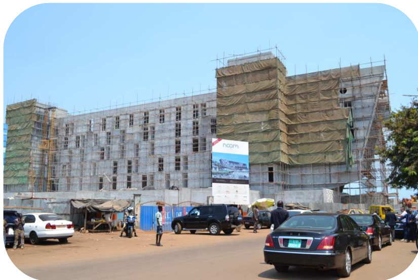
Hotel Noom 4* en construction
